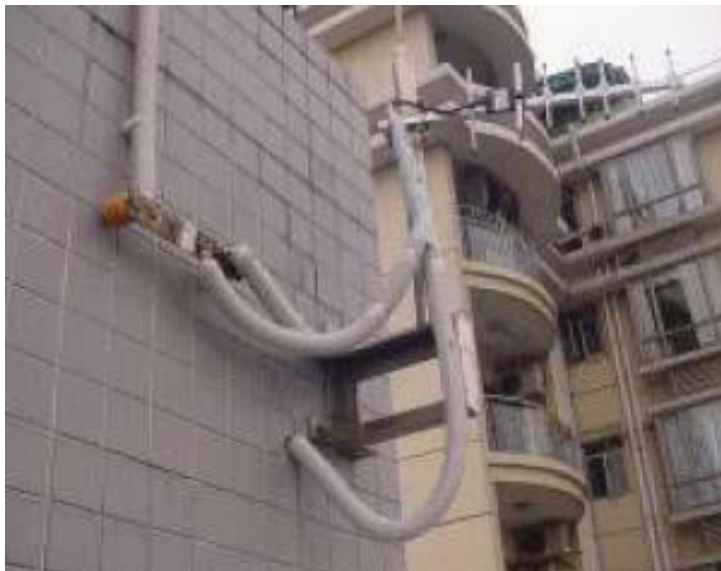
Прокладка кабеля через стены – “У”-образный изгиб
